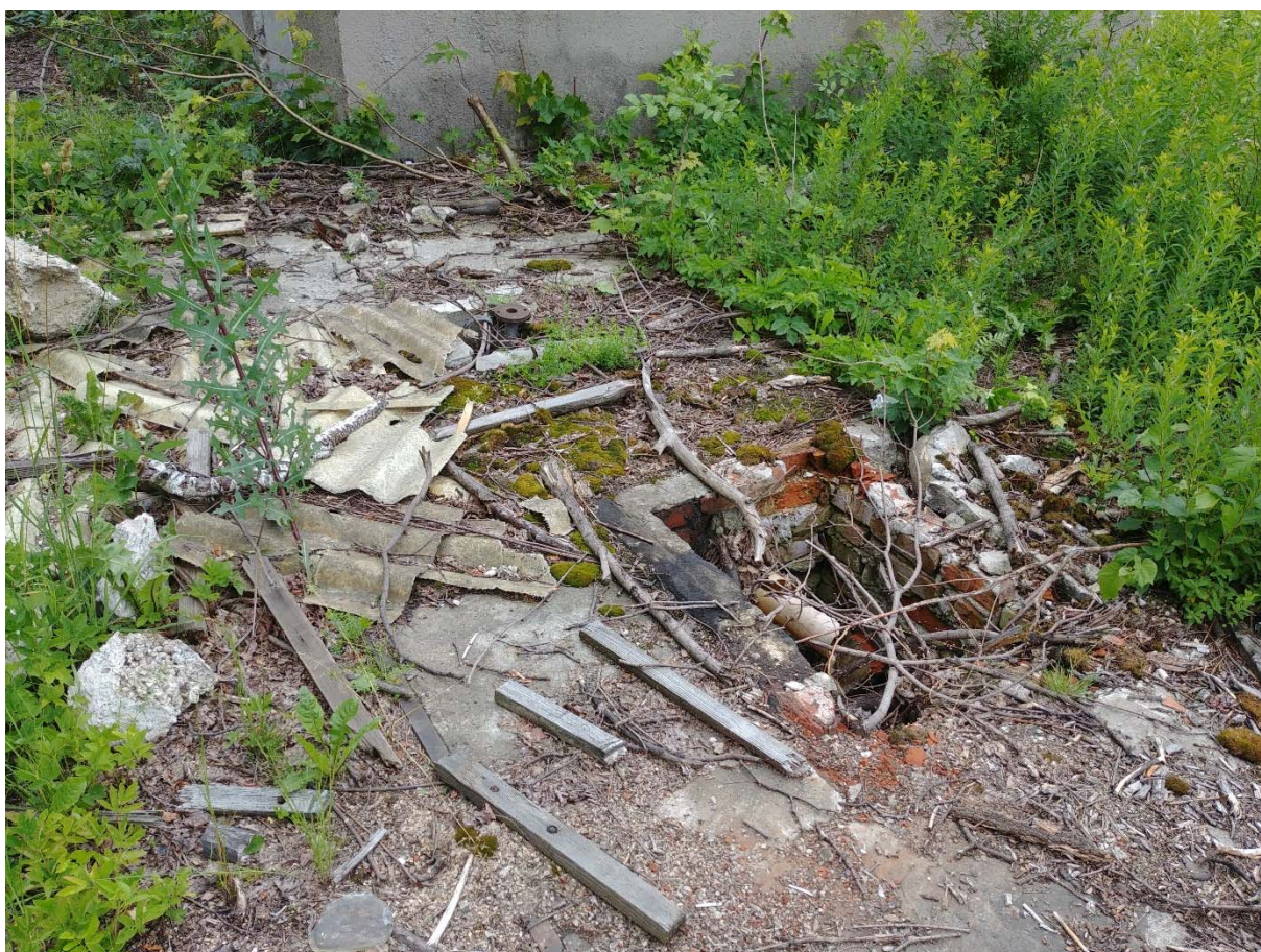
Widok wjazdu do zbiornika podziemnego
